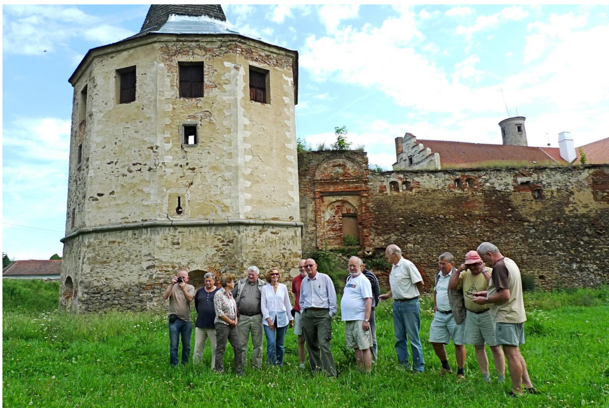
A nakonec, hezký snímek zřícenin v Červené Řečici.
